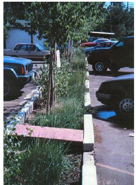
Giardino di pioggia per contrastare il ruscellamento in un parcheggio.
