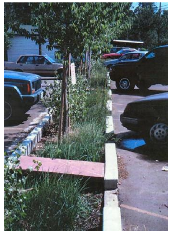
Solución de un jardín de lluvia a la escorrentía de un aparcamiento.
